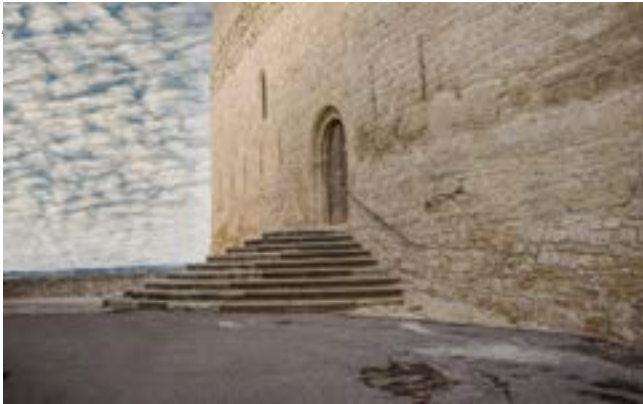
[23] Hier stört der defekte Asphalt vorne recht.
